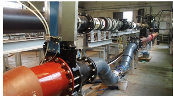
Experimentelle Kanalanlage der Berliner Wasserbetriebe (einmalig in Deutschland)
